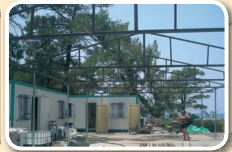
Çatının İnşası Building of the roof
